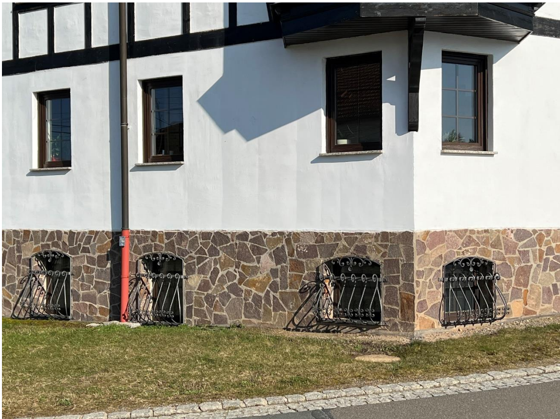
Gitter an den Kellerfenstern
